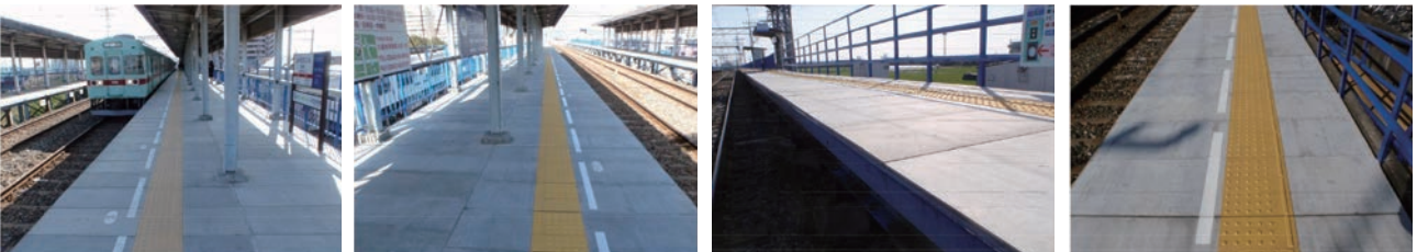
施工事例 (福岡県久留米市)
